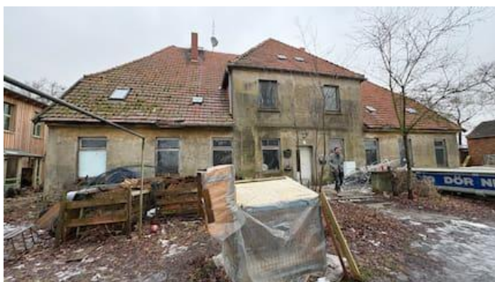
Das Gutshaus Klein Medewege soll bis 2027 saniert werden.
